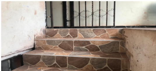
Escalera común - CJ
