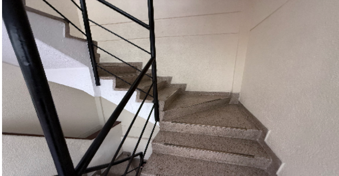
Escalera común - CJ
