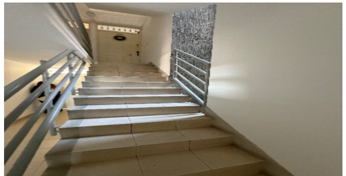
Escalera común - CJ
