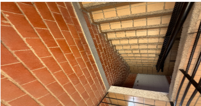
Escalera común - CJ
