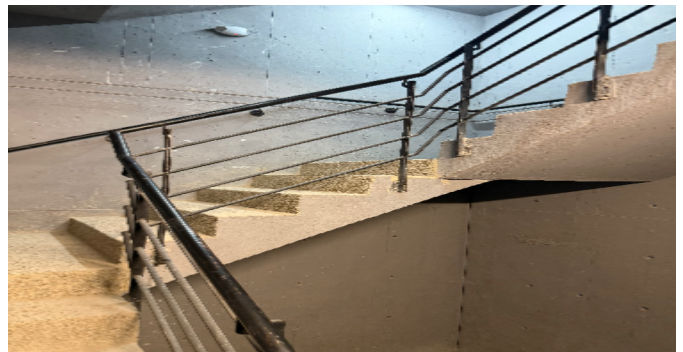
Escalera común - CJ
