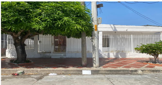
Fachada del Inmueble
