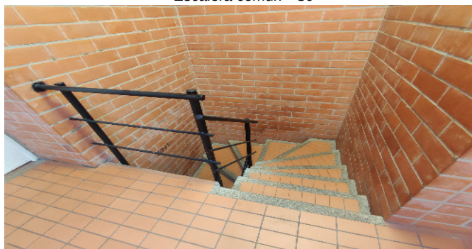
Escalera común - CJ
