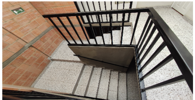
Escalera común - CJ
