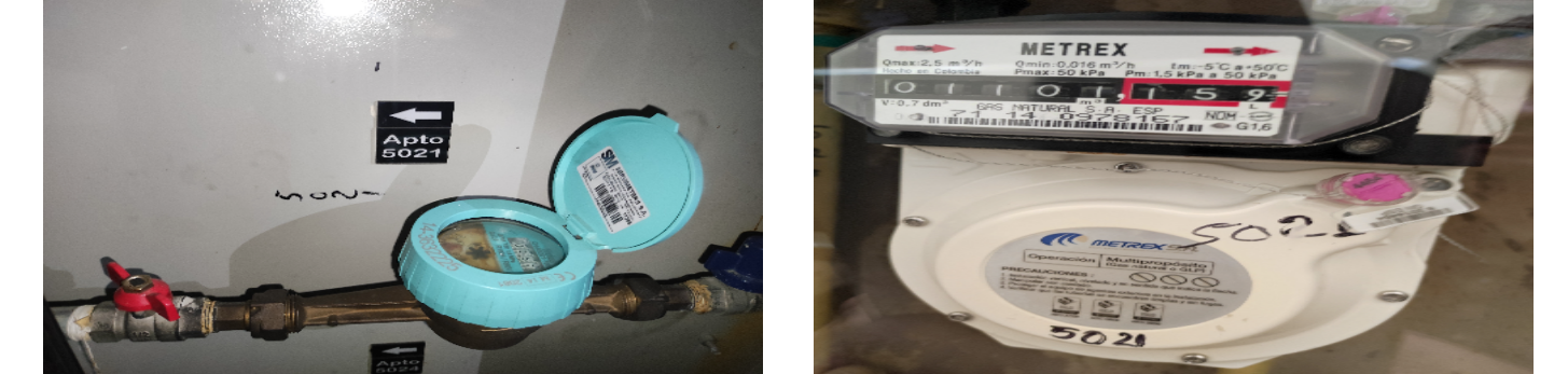
Contador de Agua Contador de Gas
