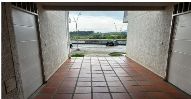
Escalera común - CJ
