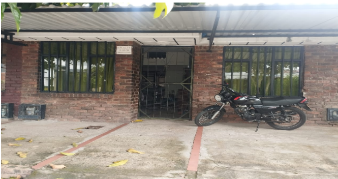
Fachada del Inmueble
