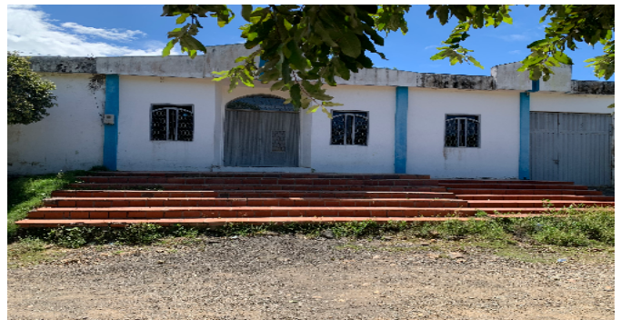
INMUEBLE FRENTE AL PREDIO
