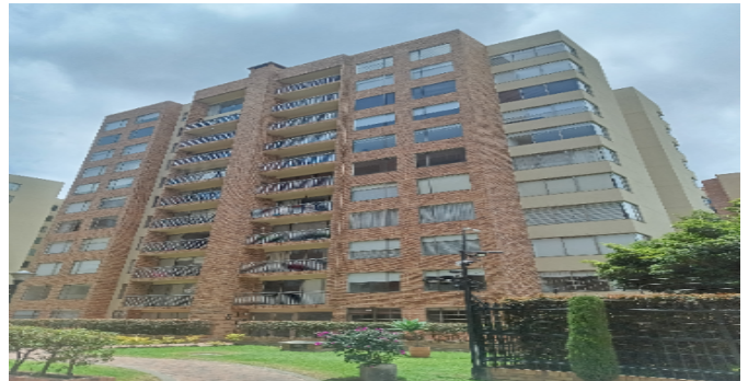
Fachada del Inmueble
