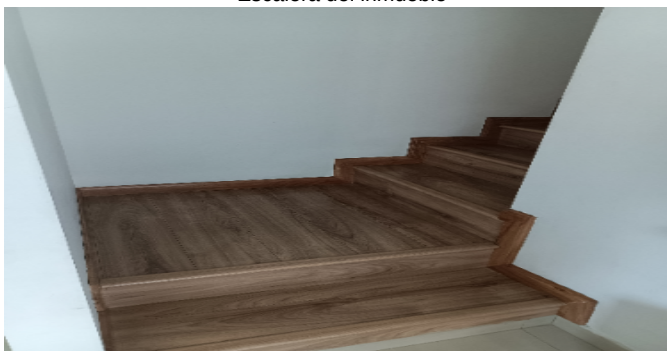
Escalera del inmueble
