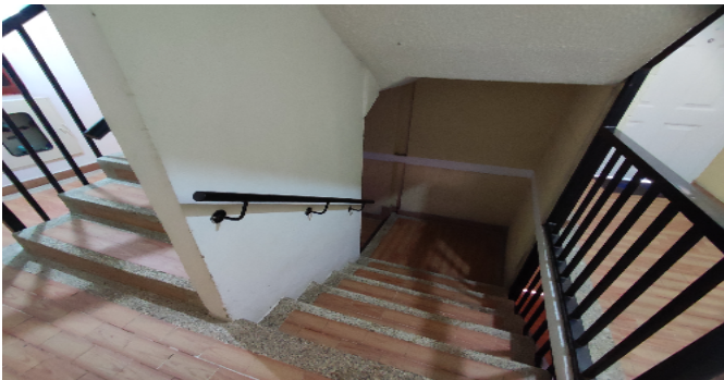
Escalera común - CJ
