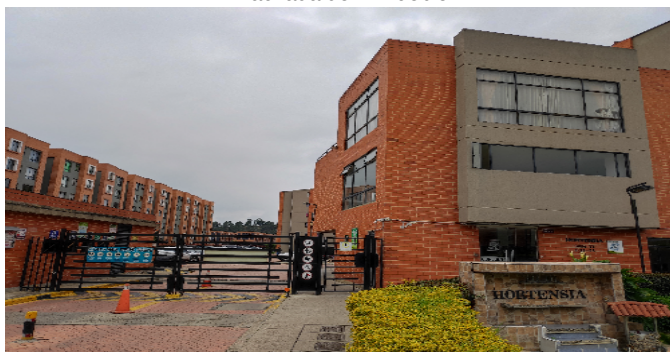
Fachada del Inmueble
