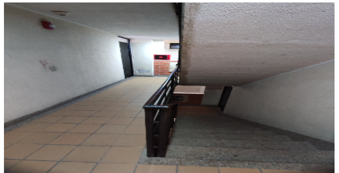
Escalera común - CJ
