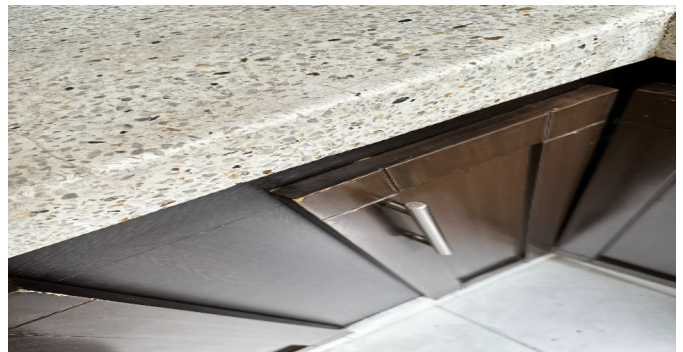
Detalle de acabados
