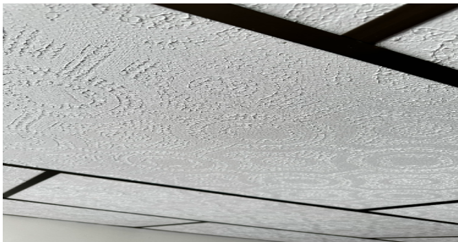
Detalle de acabados
