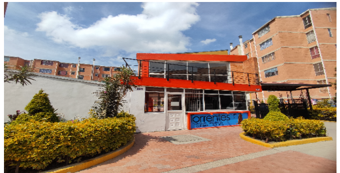
Fachada del Inmueble
