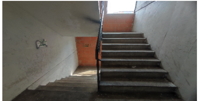
Escalera común - CJ
