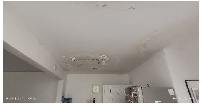
Humedad losa concreto
