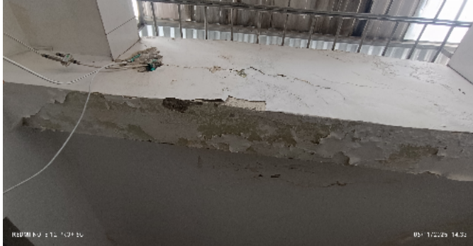
Humedad losa concreto
