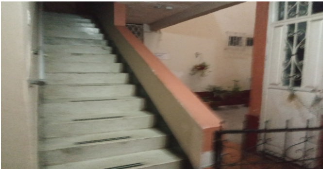
Escalera común - CJ
