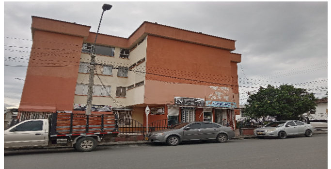
Fachada del Inmueble
