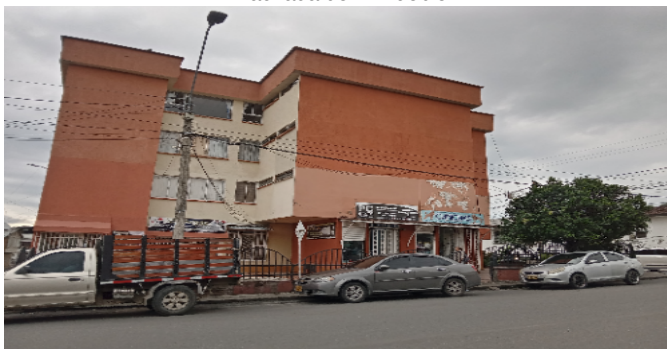
Fachada del Inmueble
