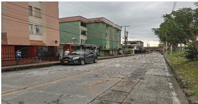
Vía frente al inmueble
