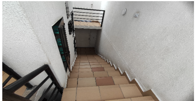
Escalera común - CJ
