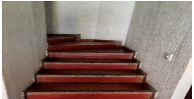
Escalera común - CJ
