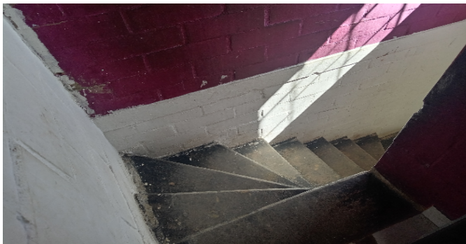
Escalera del inmueble
