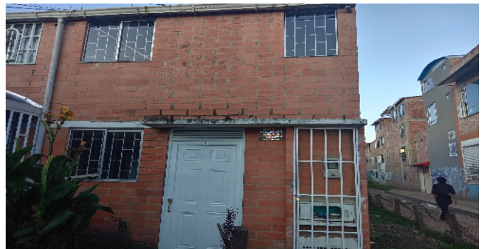
Fachada del Inmueble
