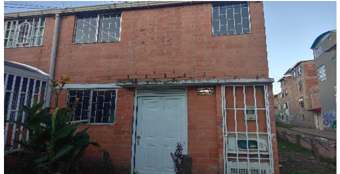
Fachada del Inmueble
