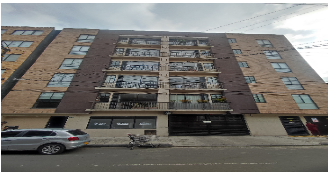
Fachada del Inmueble
