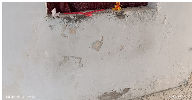
HUMEDAD MUROS
