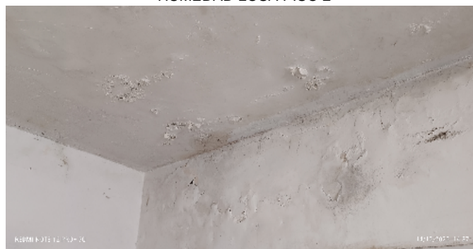
HUMEDAD LOSA PISO 2
