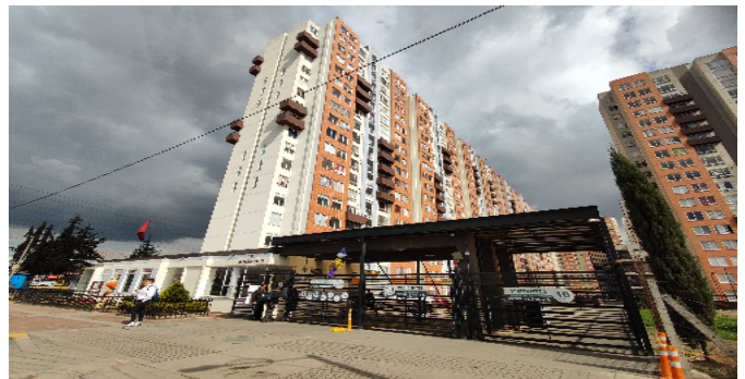
Fachada del Inmueble
