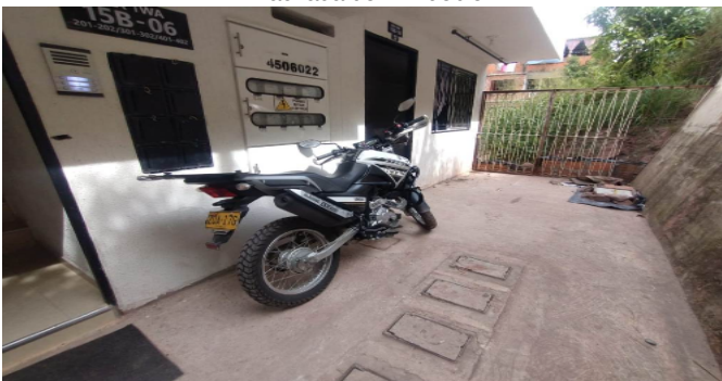
Fachada del Inmueble
