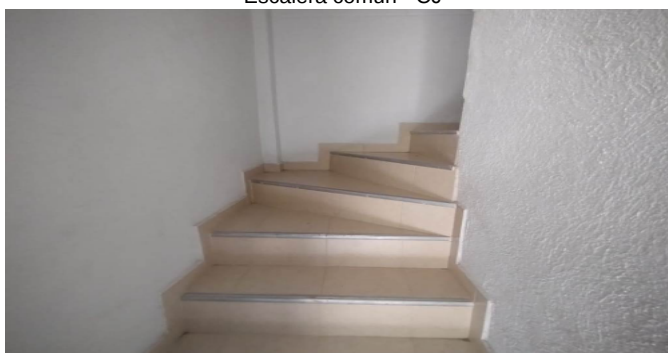
Escalera común - CJ
