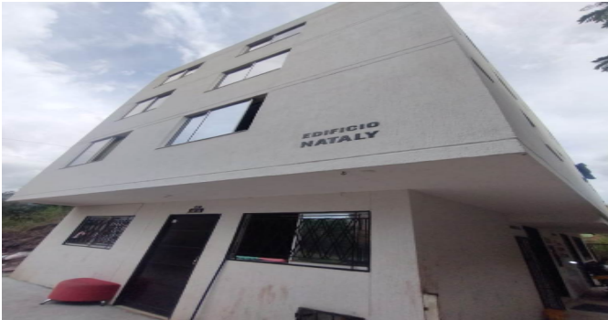
Fachada del Inmueble
