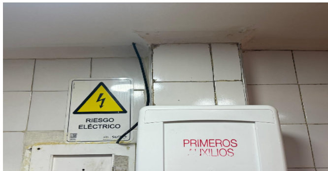
Detalle de acabados
