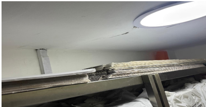
Detalle de acabados
