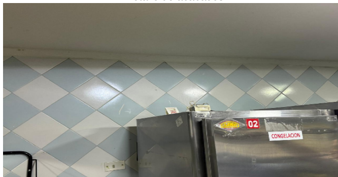
Detalle de acabados
