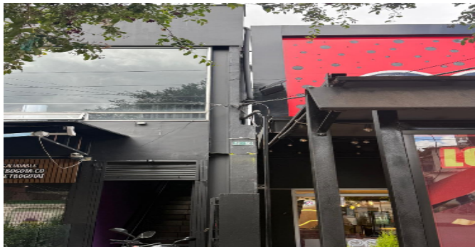
Fachada del Inmueble
