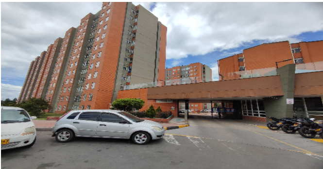
Fachada del Inmueble
