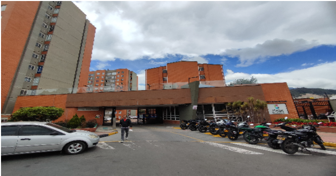
Fachada del Inmueble
