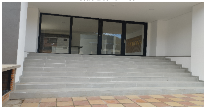
Escalera común - CJ
