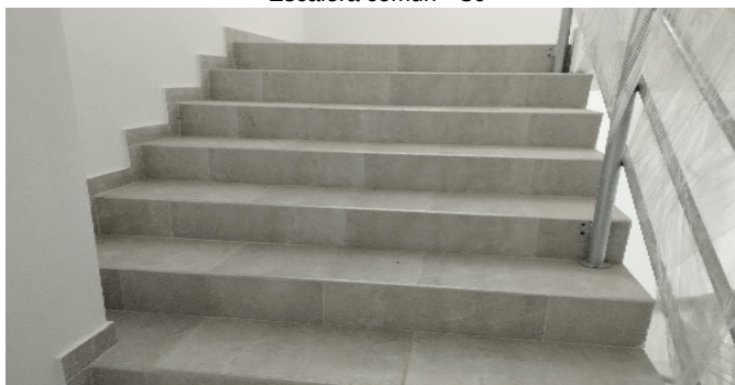
Escalera común - CJ
