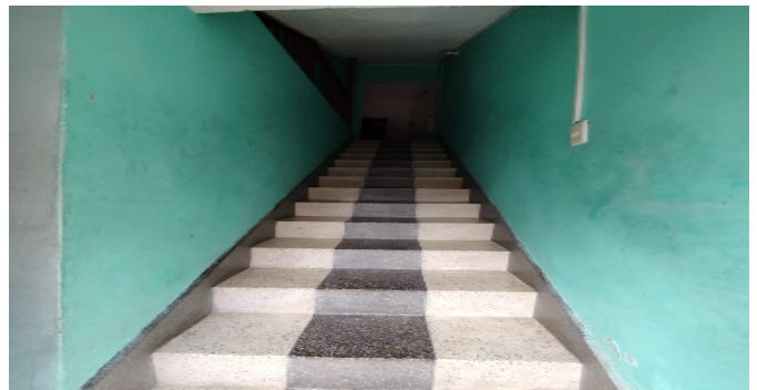
Escalera del inmueble
