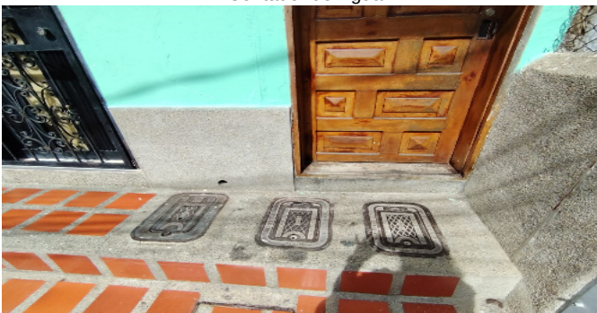
Contador de Agua
