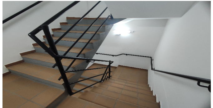
Escalera común - CJ
