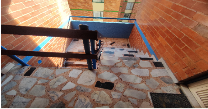
Escalera común - CJ
