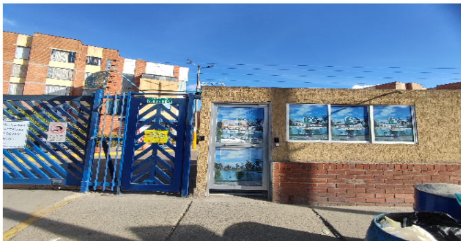
Fachada del Inmueble
