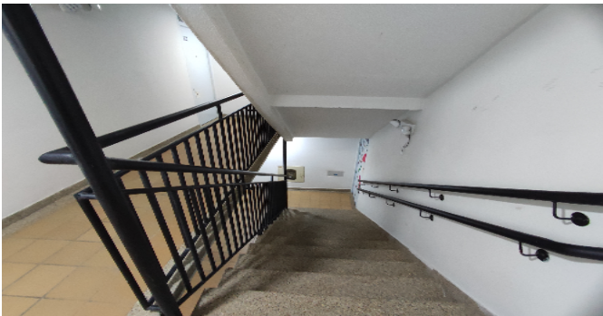
Escalera común - CJ
