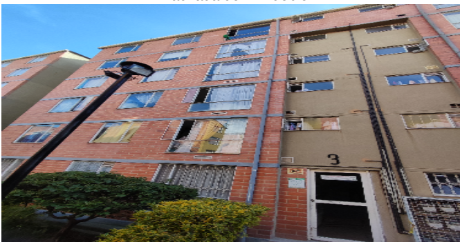
Fachada del Inmueble
