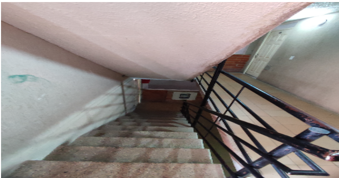
Escalera común - CJ
