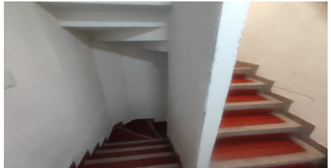
Escalera común - CJ
