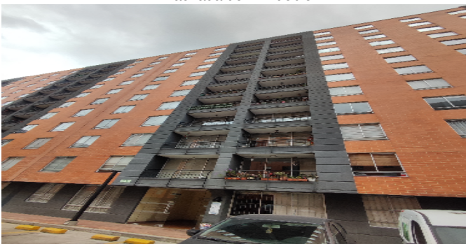
Fachada del Inmueble
