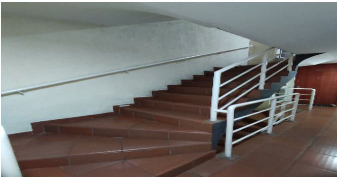
Escalera común - CJ
