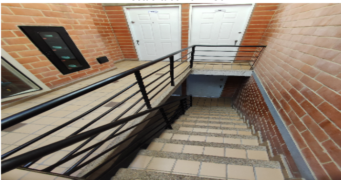
Escalera común - CJ
