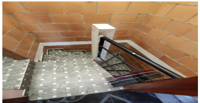
Escalera del inmueble
