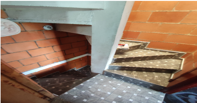
Escalera del inmueble
