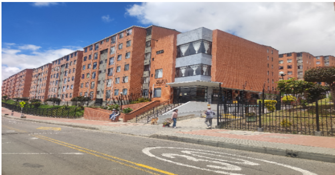
Fachada del Inmueble
