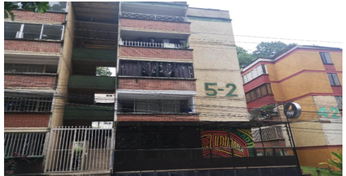
Fachada del Inmueble
