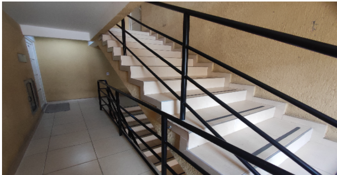
Escalera común - CJ
