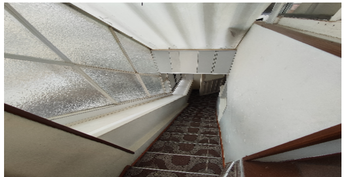
Escalera del inmueble
