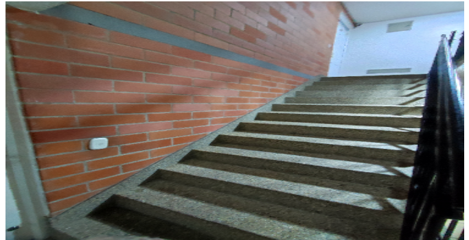
Escalera común - CJ
