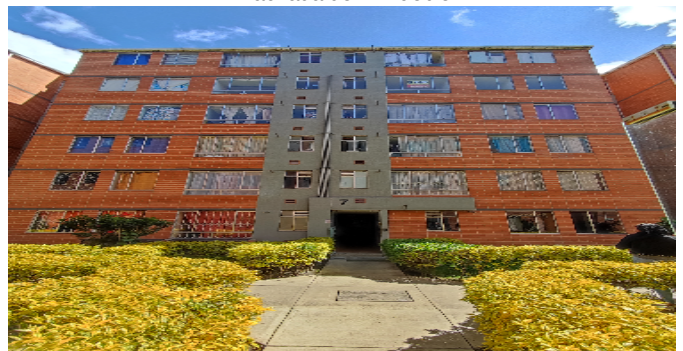
Fachada del Inmueble
