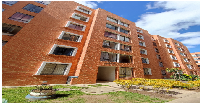
Fachada del Inmueble
