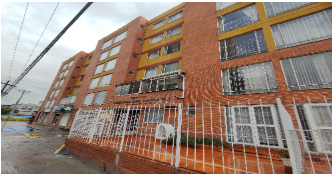
Fachada del Inmueble
