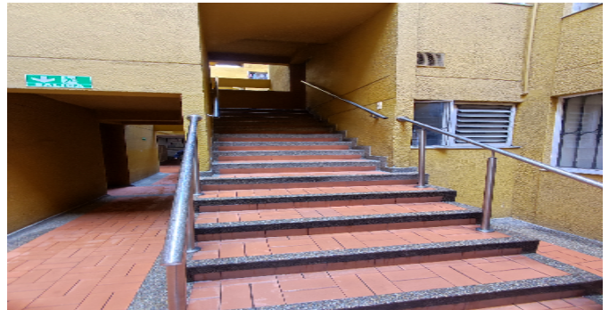
Escalera común - CJ
