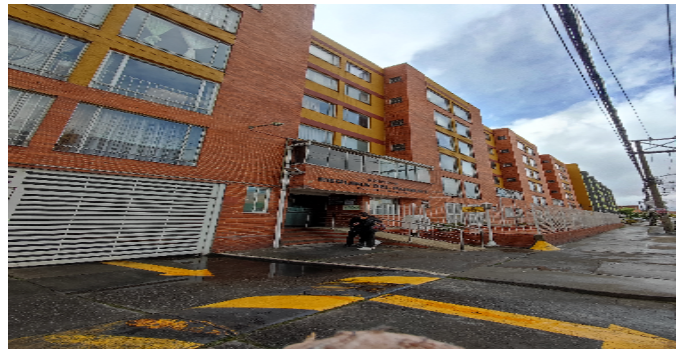
Fachada del Inmueble
