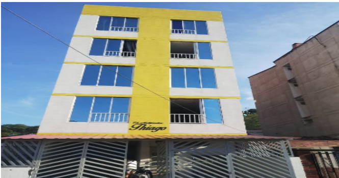
Fachada del Inmueble
