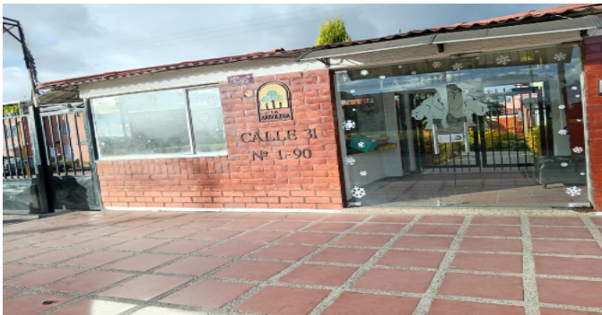
Fachada del Inmueble
