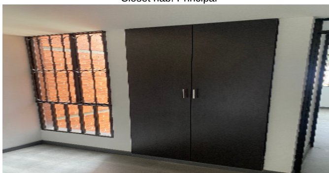
Closet hab. Principal
