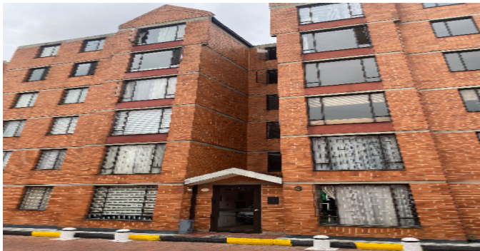
Fachada del Inmueble
