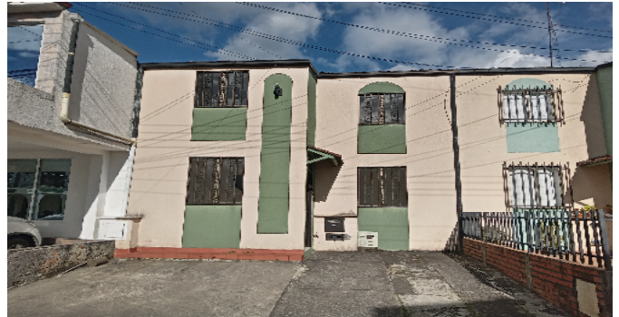
Fachada del Inmueble
